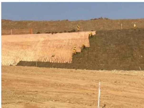
Foto 7: Plantio de grama (cobertura de talude) no vertedouro (30/08/2021)
