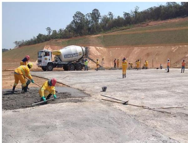
Foto 6: Concretagem (concreto magro fck= 10 MPa), da laje do Canal de Aproximação (22/08/2021)
