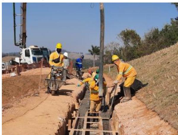
Foto 8: Concretagem da canaleta das bermas (30/08/2021)
