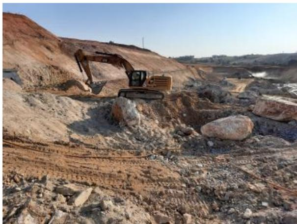
Foto 5: Escavação e remoção de material de 3ª categoria após desmonte de rocha (galeria de desvio) (26/09/2021)
